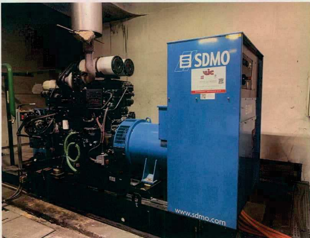
GROUPE ÉLECTROGÈNE DE SECOURS
